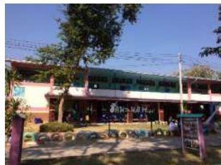
อาคารเรียน สปช.105/29 ปีที่สร้าง 2558
