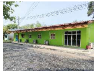
อาคารอเนกประสงค์/ โรงอาหาร/โรงฝึกงาน/ หอประชุมสปช. 203/26ปีที่สร้าง 2531
