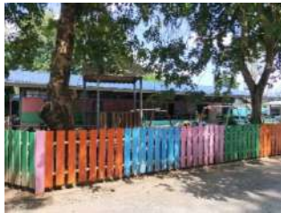
อาคารเรียน สปช.102/26 ปีที่สร้าง 2525
